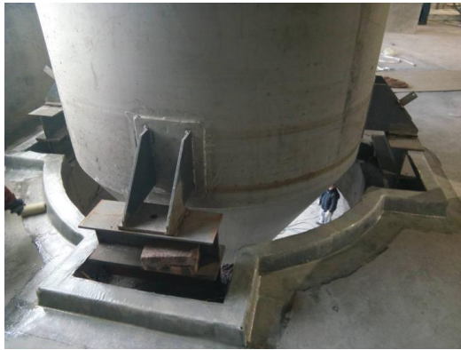
围堰玻璃钢施工
