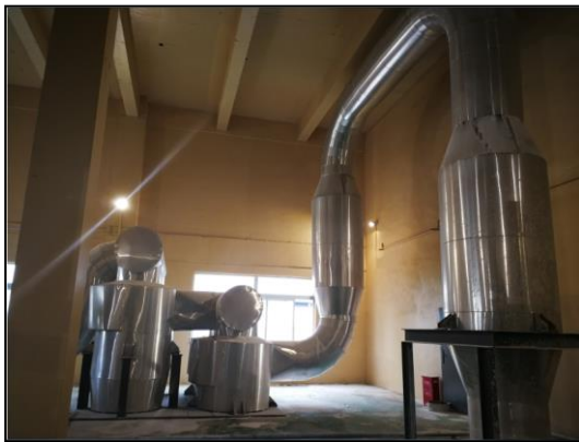
碳酸锂车间旋风除尘器
