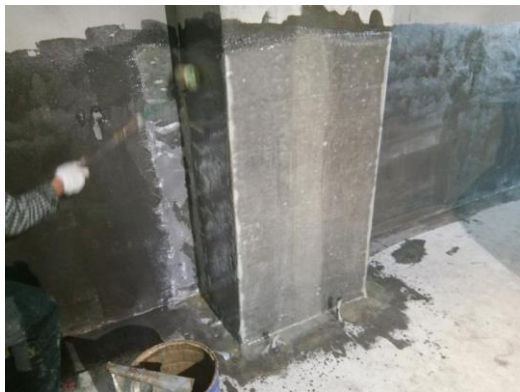
墙裙玻璃钢施工
