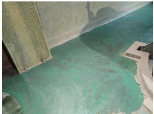
墙裙玻璃钢施工
