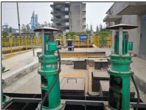
污水处理中清水回用池污水一体化预处理系统（地埋）
