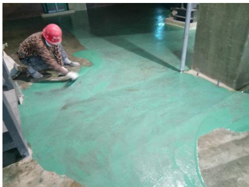
自流地坪封闭底漆施工
