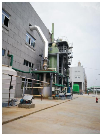
酸化窑废气水膜碱液喷淋+碳酸 钙乳液洗涤+电除雾
