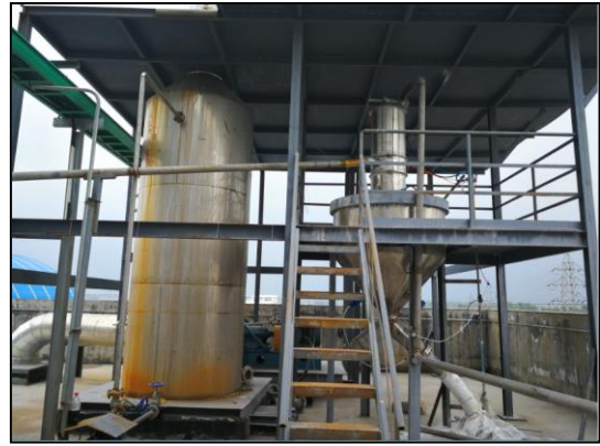
氢氧化锂车间旋风除尘+水膜除尘器
