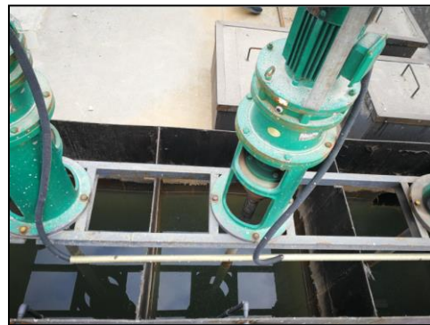
污水处理站调节池污水处理站“中和+混凝沉淀+过滤”设备
