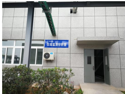
蒸汽锅炉房在线监测分析室
