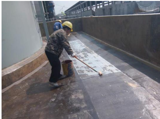
硫酸罐区玻璃钢施工
