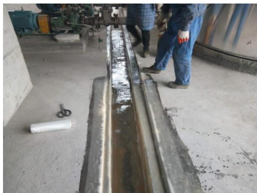
地沟玻璃钢施工
