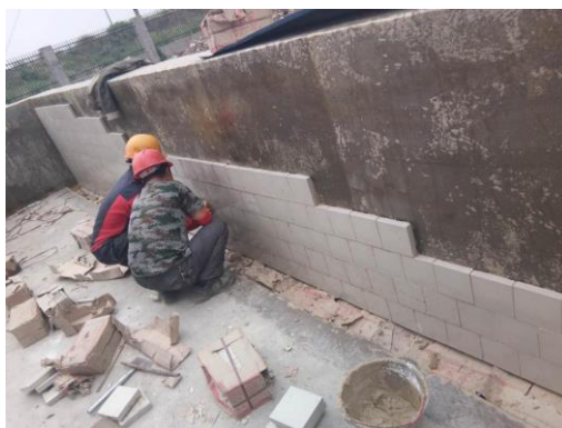
硫酸罐区耐酸砖施工
