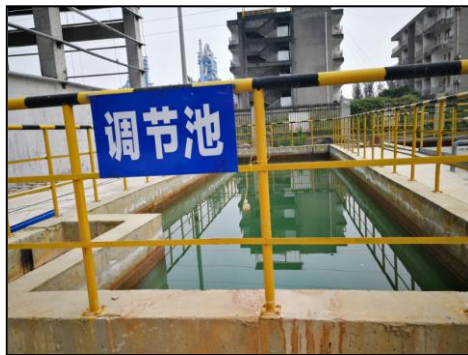
污水处理站调节池污水处理站“中和+混凝沉淀+过滤”设备
