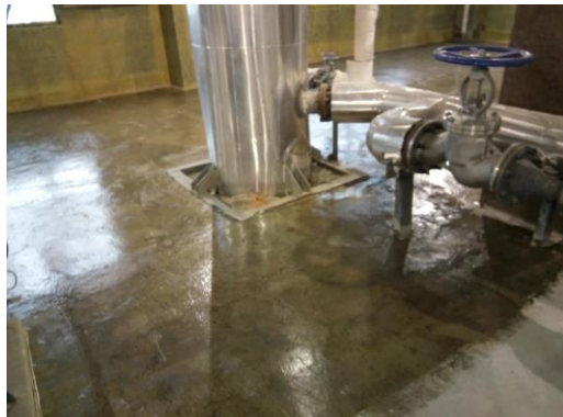
自流地坪底漆施工
