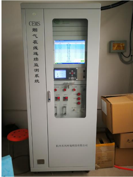
蒸汽锅炉房在线监测系统
