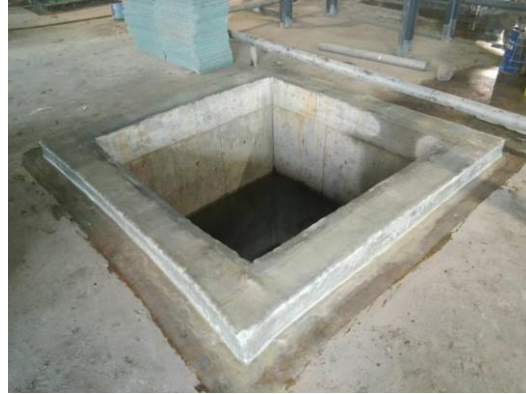
围堰玻璃钢施工
