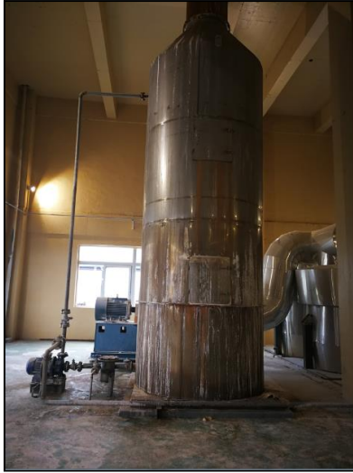
碳酸锂车间水膜除尘器
