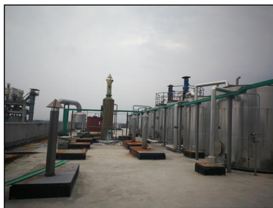
碳酸锂车间碱液喷淋
