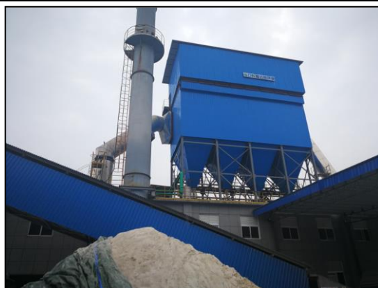
回转窑尾气高温布袋+SCR 脱硝回转窑尾气和烘干废气布袋除尘器
