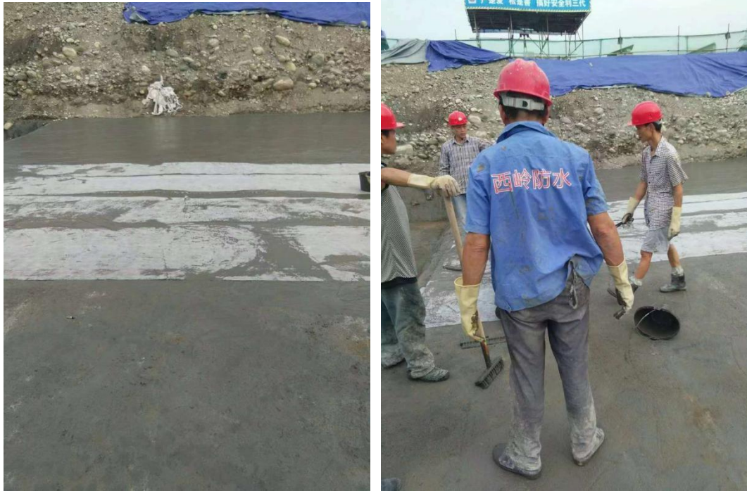
水池基础及防渗施工
