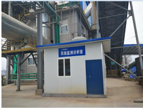
回转窑废气在线监测分析室
