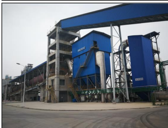
回转窑尾气高温布袋+SCR 脱硝回转窑尾气和烘干废气布袋除尘器
