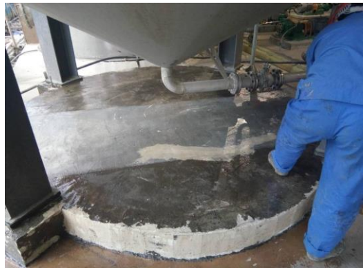
设备基础玻璃钢施工
